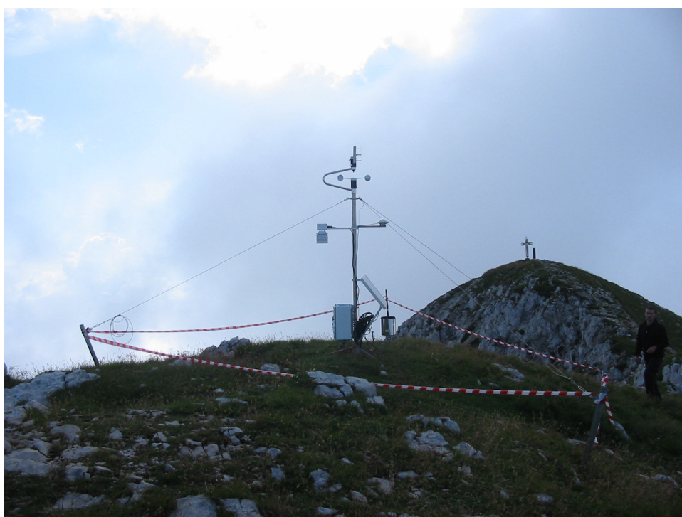
Figura 4.8. La stazione completamente operativa, protetta e segnalata (foto scattata il 23/07/2005).
