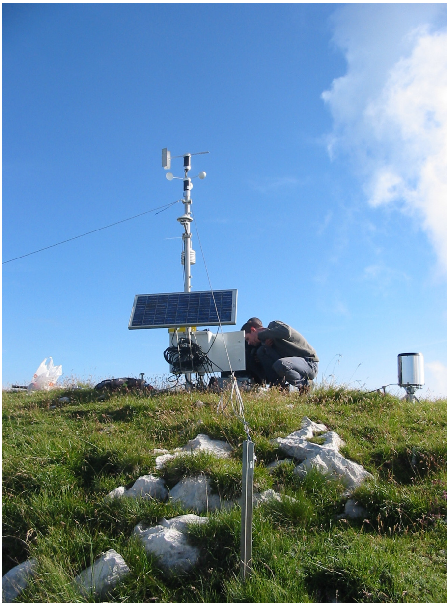
Figura 4.4. Verifica della stazione dopo l'installazione, si nota sulla destra il pluviometro (foto scattata la mattina del 23/07/2005.).
