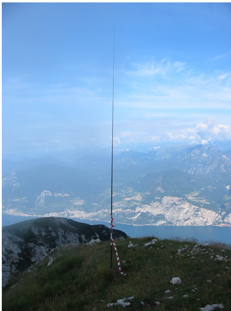
Figura 4.5. Il parafulmini realizzato a protezione della stazione (foto scattata il 23/07/2005).
